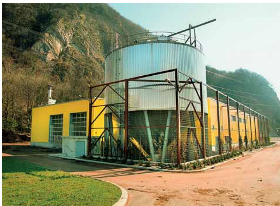
Vue au sol de l'usine avec son silo extérieur caractéristique.
