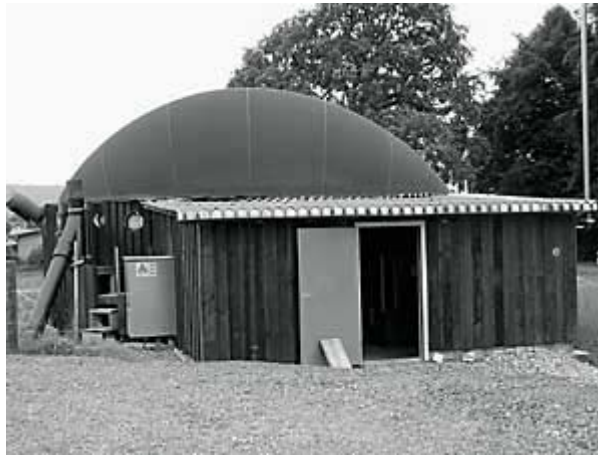
Une centaine de «digesteurs», où les déchets organiques sont dégradés par des bactéries, devraient pousser en Suisse dans les dix ans (ici à Dietlikon, ZH)
