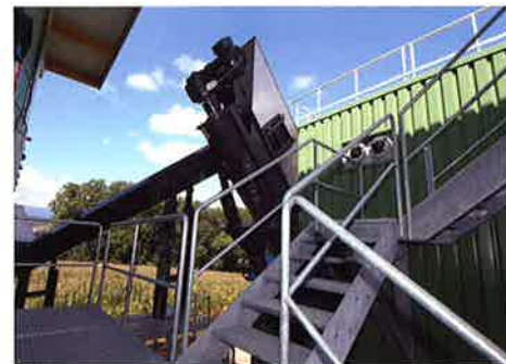
Vis d'alimentation et d'introduction de la matière dans le fermenteur
