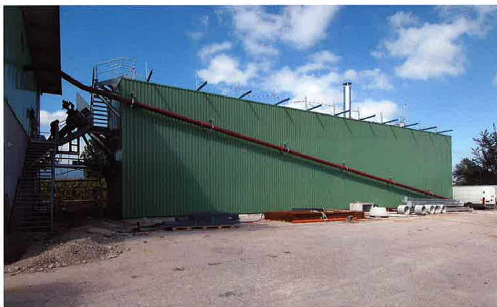
Bâtiment du fermenteur
