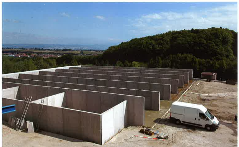
Vue des serres de compostage (en cours de réalisation)
