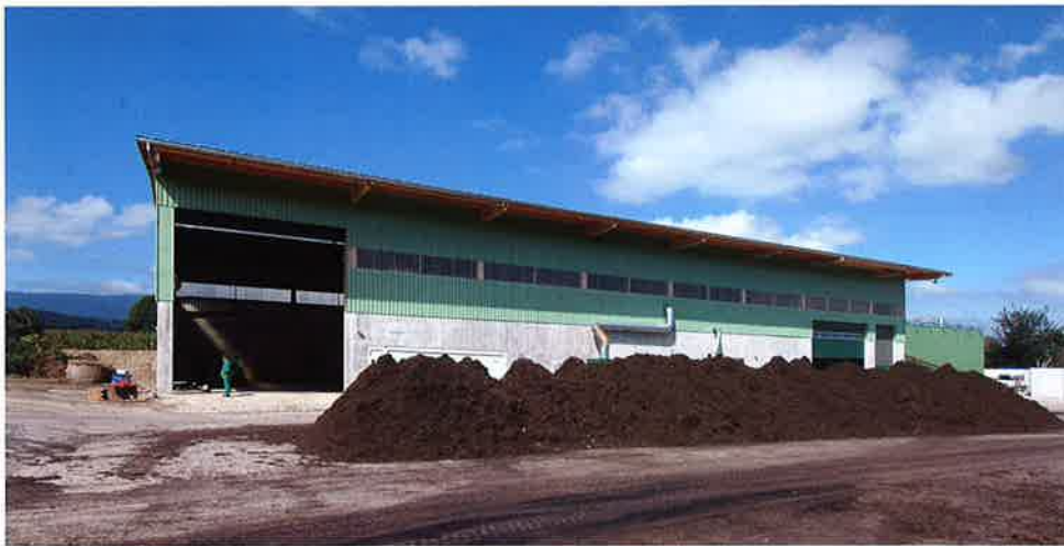
Halle de réception et aire de stockage du compost
