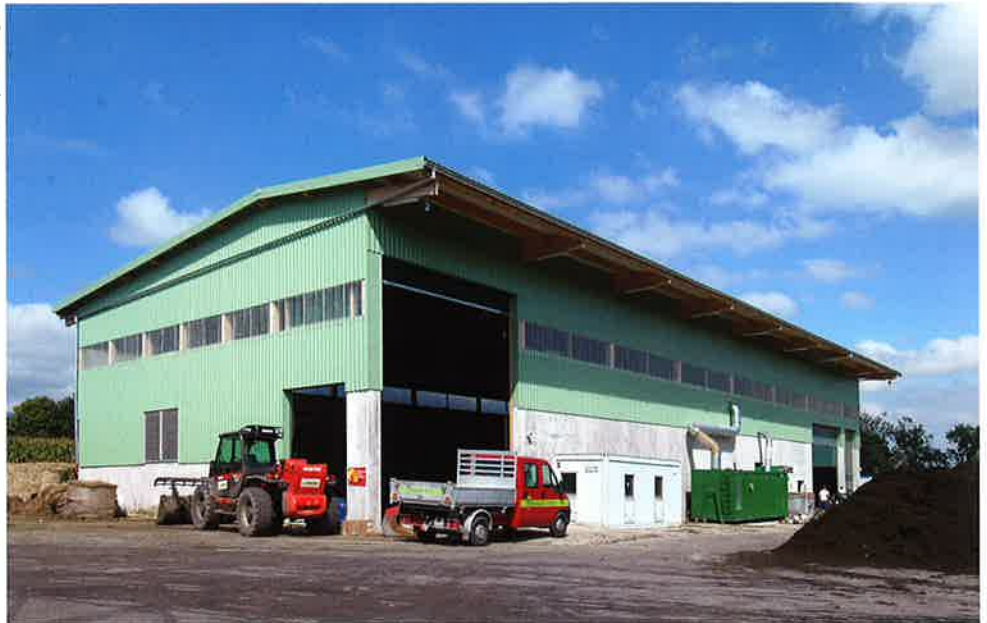
Vue de la halle de réception/préparation des déchets et de stockage du digestat
